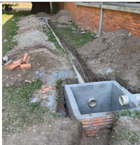
Prédio 7 – reforma da rede de escoamento pluvial.
