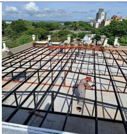
Prédio 5 – execução da nova cobertura.
