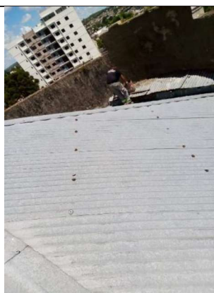
Santana do Livramento – reconstrução do telhado, danificado pelo temporal.
