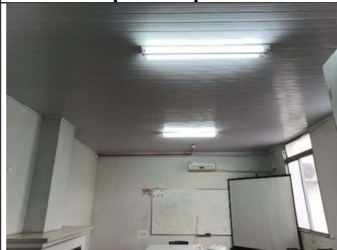
Santana do Livramento – reconstrução do forro danificado pelo temporal.
