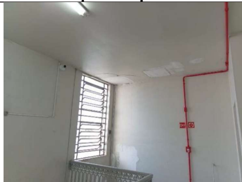
Santana do Livramento – recomposição de estruturas de gesso, danificadas pelo temporal.
